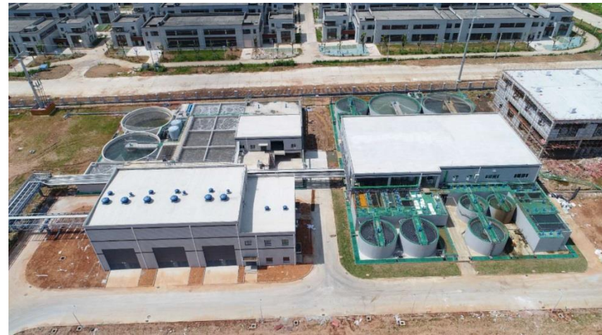
汙水處理廠+變電站
